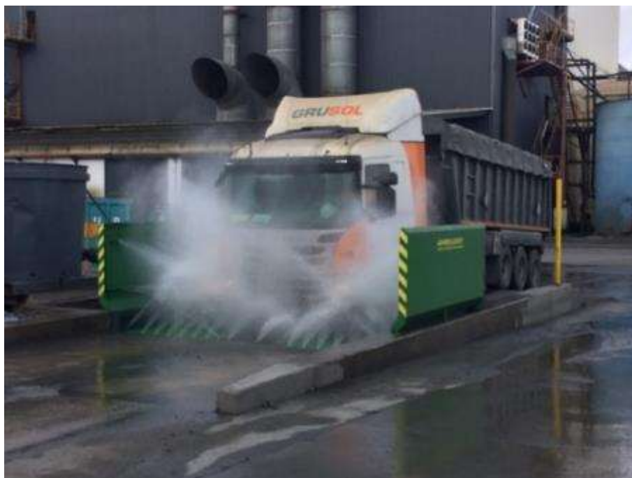
Figura 24 – Lavagem de rodados: camião concentrado
