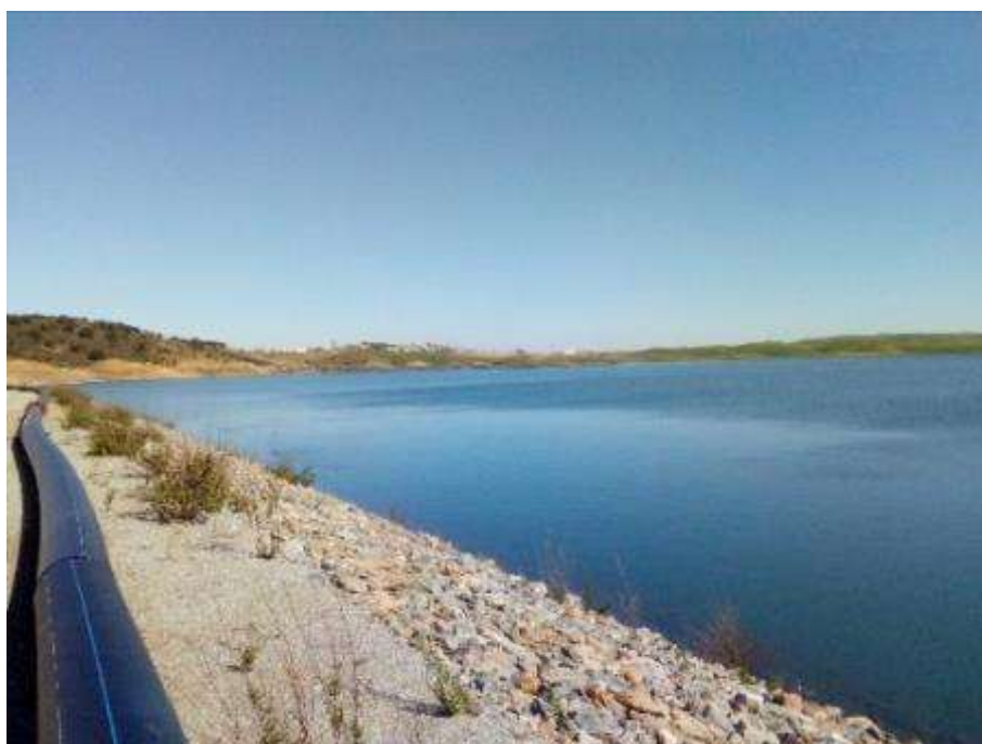
Figura 20 – Instalação de resíduos “BE-BAC” a partir do seu coroamento
