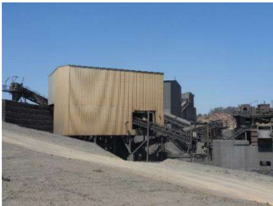
Figura 22 – Vista das telas transportadoras: britagem
