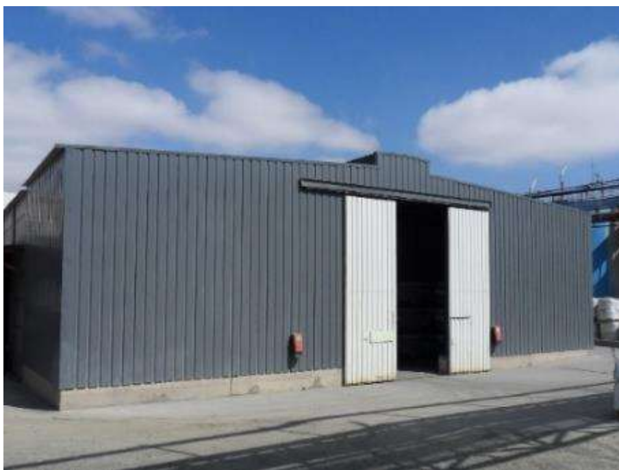
Figura 5 – Fachada exterior do edifício dos reagentes
