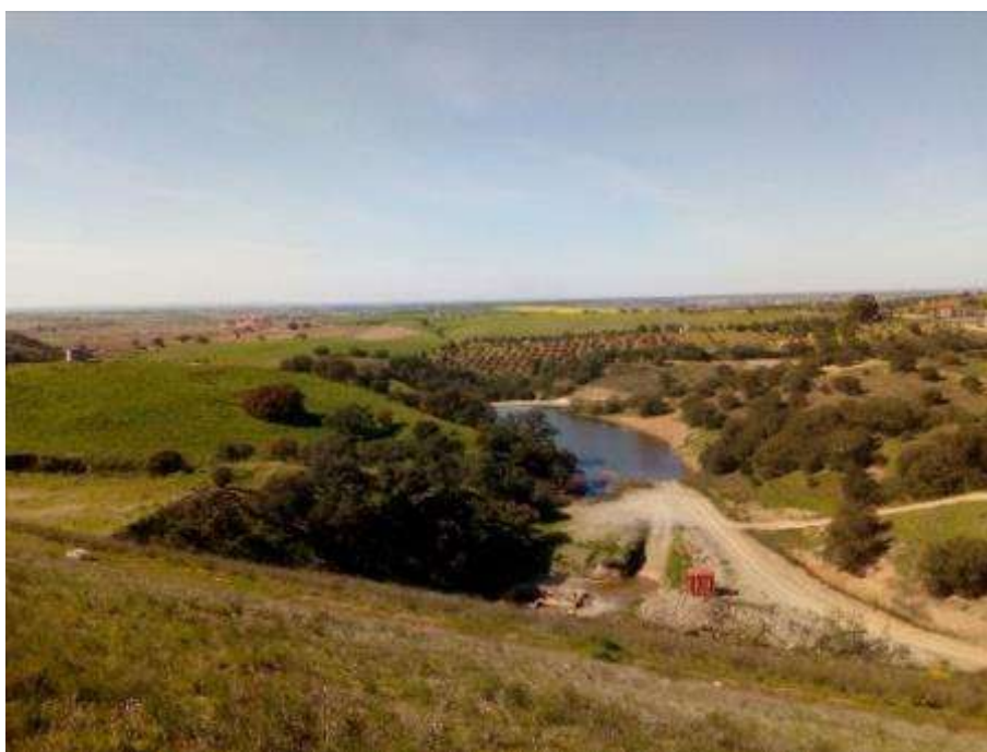
Figura 19 – Vista jusante da “BE-BAC”
